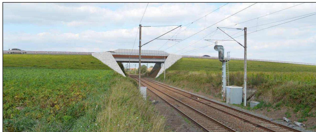
Ouvrage d'art n°5 sur voies ferrées
