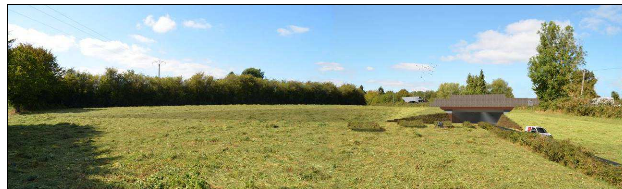
Exemple de Passage à Faune –Ouvrage d'art n°1
