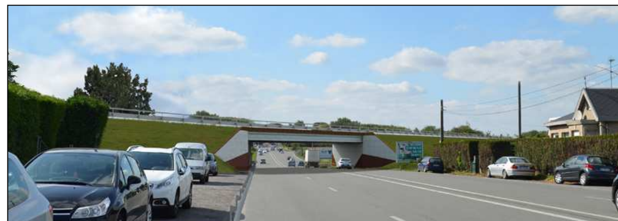
Ouvrage d'art n°3 RD649
