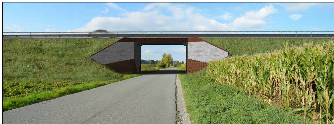
Ouvrage d'art n°8 - Franchissement de la RD136
