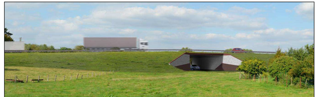
Ouvrage d'art n°6 - Franchissement de la rue de la Flamenne
